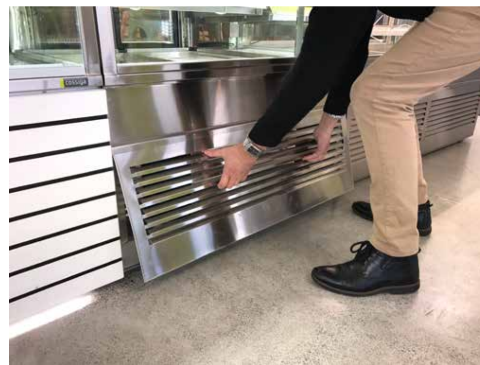
拆下格栅，即可以触及冷凝器
