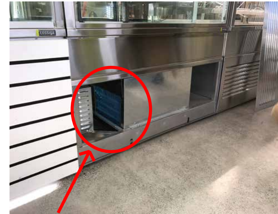
拆下格栅，即可以触及冷凝器
